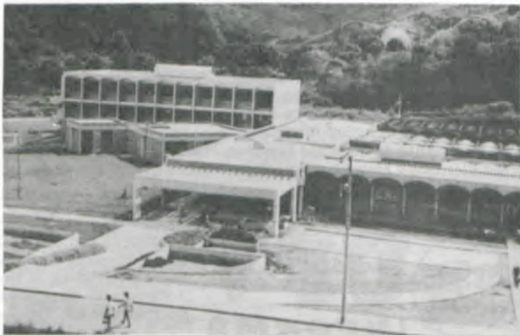
Vista do «hall» de acesso do DZO.
