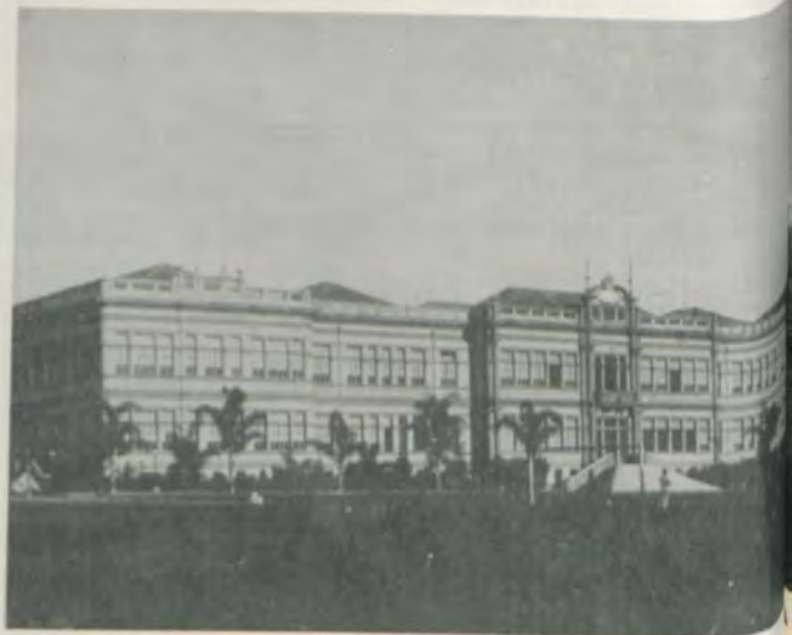
A obra concluída.
