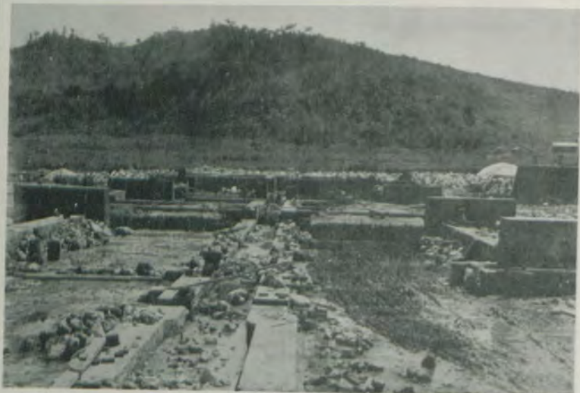
Construção do edificio principal.
