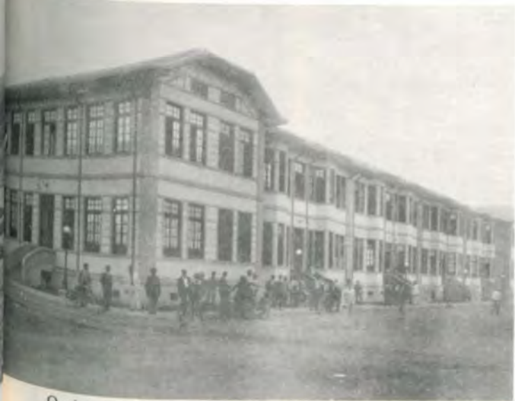
O alojamento dos estudantes, após a construção.
