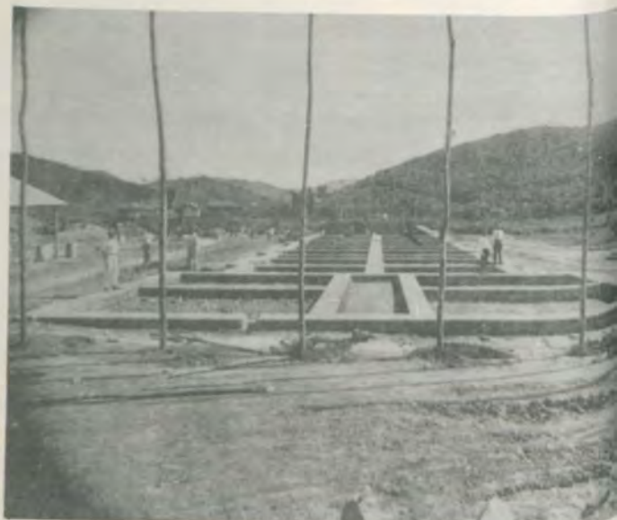
Construção do alojamento dos estudantes.
