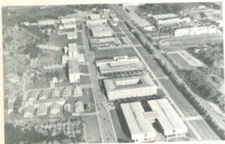
Vista parcial do «campus» da UFV.
