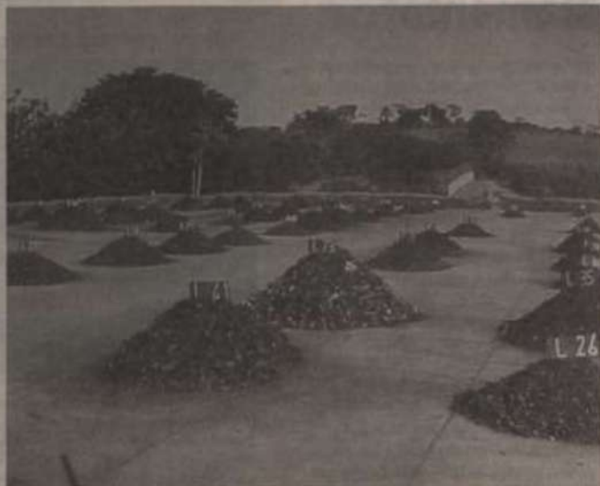
Pátio de compostagem da Usina de Guiricema
