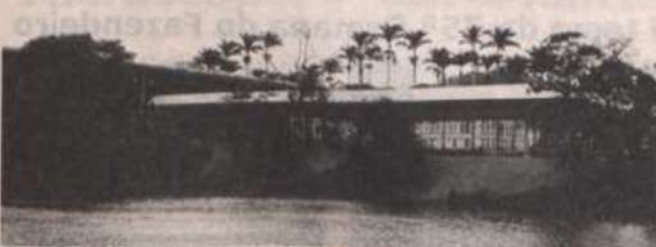
O Espaço Multiuso foi construído atrás do Centro de Vivência
