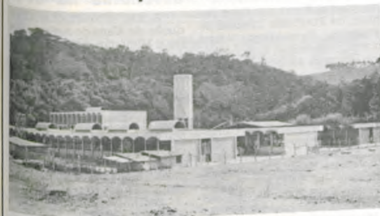
A foto mostra as obras do quarto módulo do Departamento de Zootecnia, que abrigará os laboratórios.
